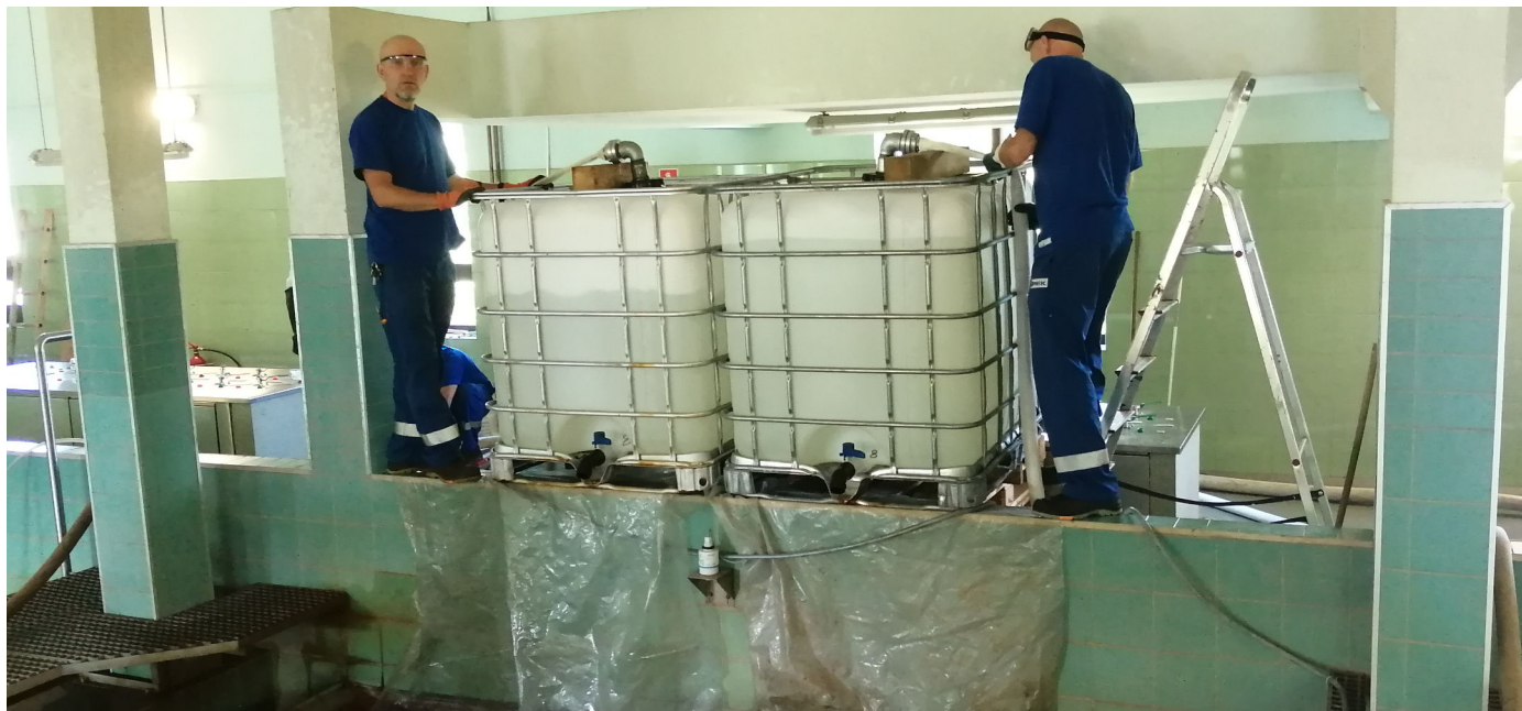
Rys. 5. Zalewanie złoża roztworem siarczanu manganu (fot. Marcin Kos)
