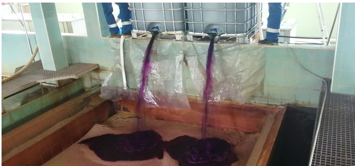
Rys. 6. Zalewanie złoża roztworem nadmanganianu potasu (fot. Marcin Kos)
